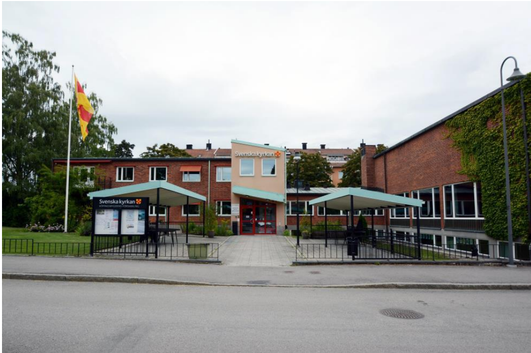
Församlingshemmet's södra fasad med huvudingång och cykelställ framför byggnaden.
