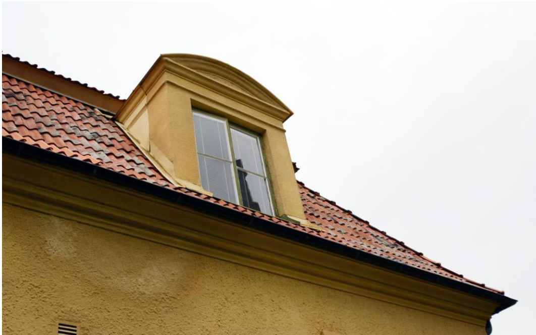
Takkupa samt takfot med dekorativa listverk i slätputs.
