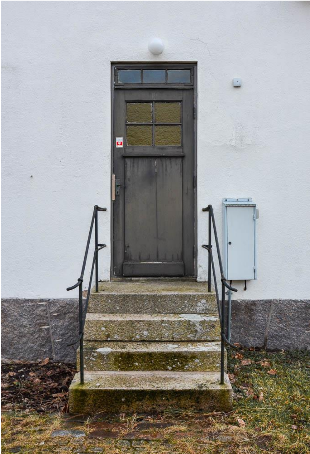
Närbild på köksingången mot norr med originaldörr. Bilden visar även den grovhugna sockeln i granit.
