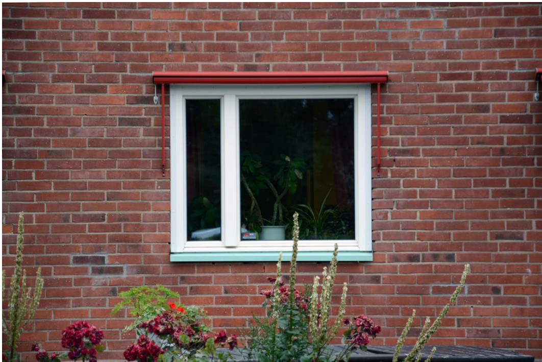
Fönster på expeditionsflygelns södra fasad, med ärggrönmålad kopparplåt och röda markiser.
