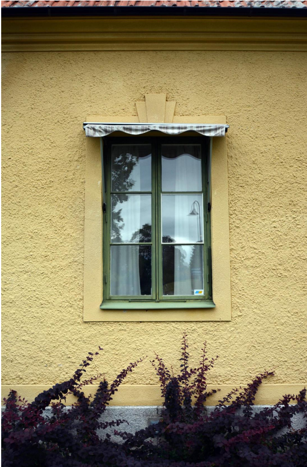
Spröjsat träfönster målat i grön kulör, fönsteromfattningar och dekorativt överstycke i slätputs.
