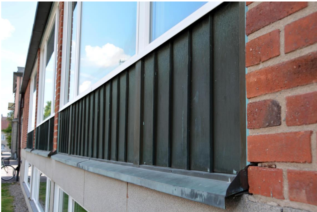
Parti med kopparplåt nedanför fönster.
