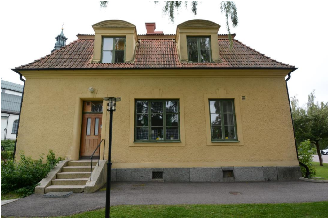
Fasad åt öster. Byggnadens vindskupor, granitsockel med fasat avslut och fönstersättning syns här. Till vänster syns även byggnadens köksingång.
