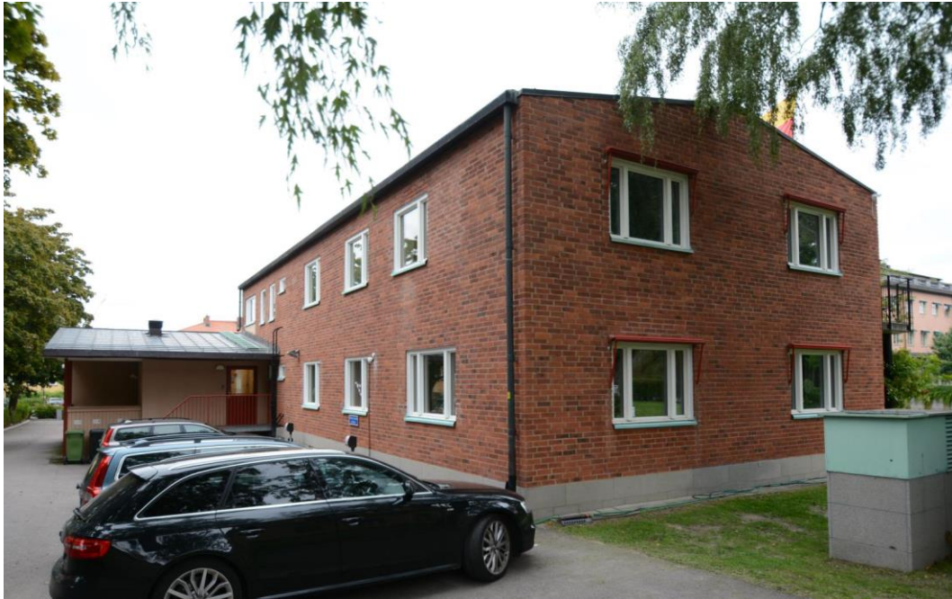
Expeditionsflygeln mot nordöst med sin rätlinjiga byggnadskropp, flacka sadeltak och röda fasadtegel. Här syns även expeditionsflygelns fönstersättning och rutindelning.
