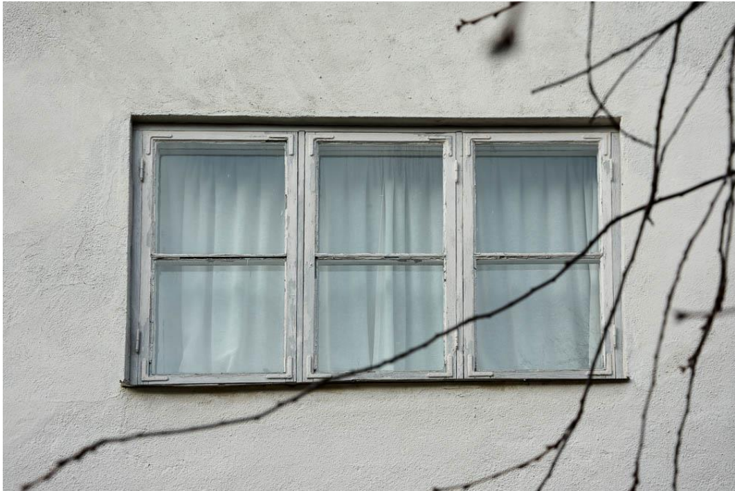
Närbild fönster, fasad mot söder.
