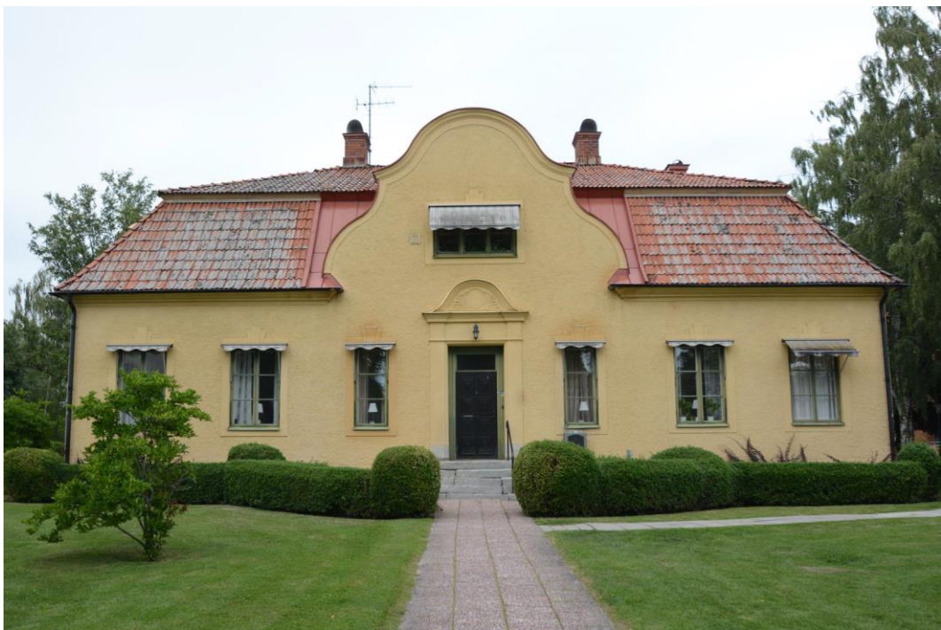
Fasad åt syd. Här syns byggnadens mansardtak täckt med lertegel och de två skorstenarna. Den symmetriska fönstersättningen visas på denna bild och även byggnadens tillhörande trädgård med öppen gräsmatta, träd, buskar och plattsättningar.
