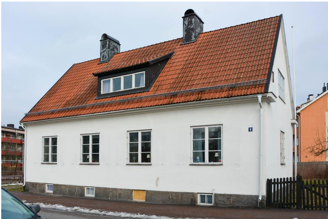
Klockaregårdens sydvästra fasad. Här syns sadeltaket täckt av lertegel och byggnadens två skorsternar.
