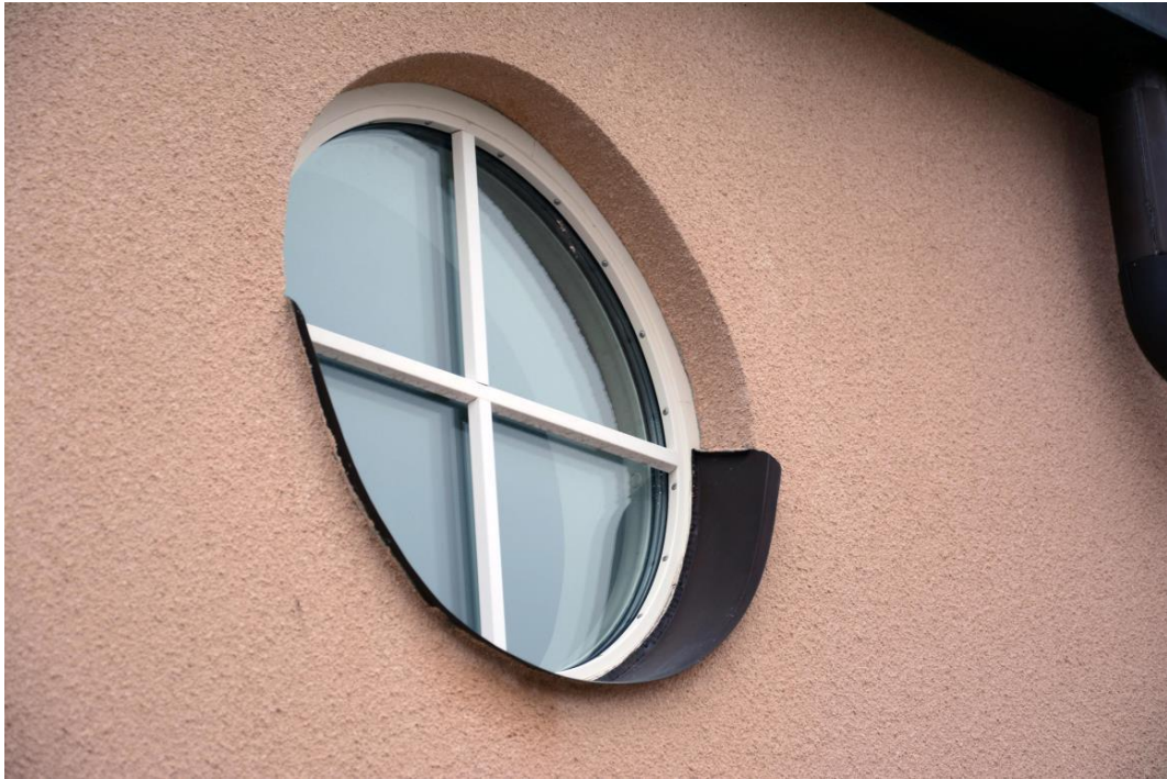
Fönster på församlingsflygelns södra sida med fönsterbleck i kopparplåt.
