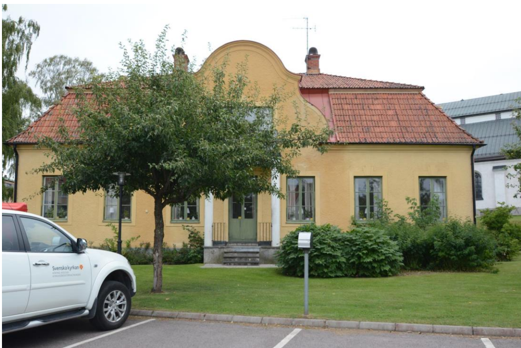
Fasad åt norr med balkong/farstu och entréingång syns i mitten av byggnaden.
