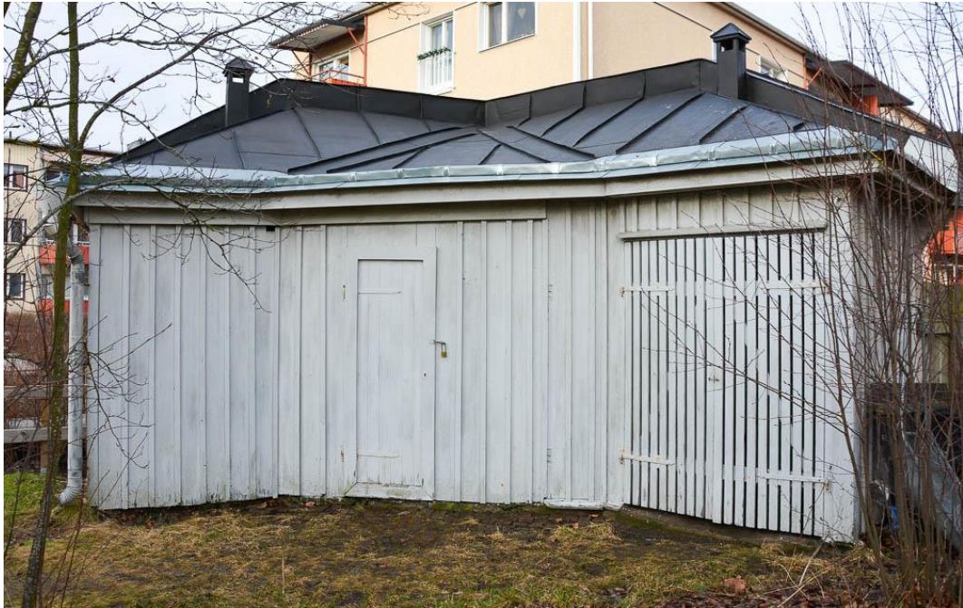
Uthusets fasad mott norr. Här syns takets utformning i falsad plåt.
