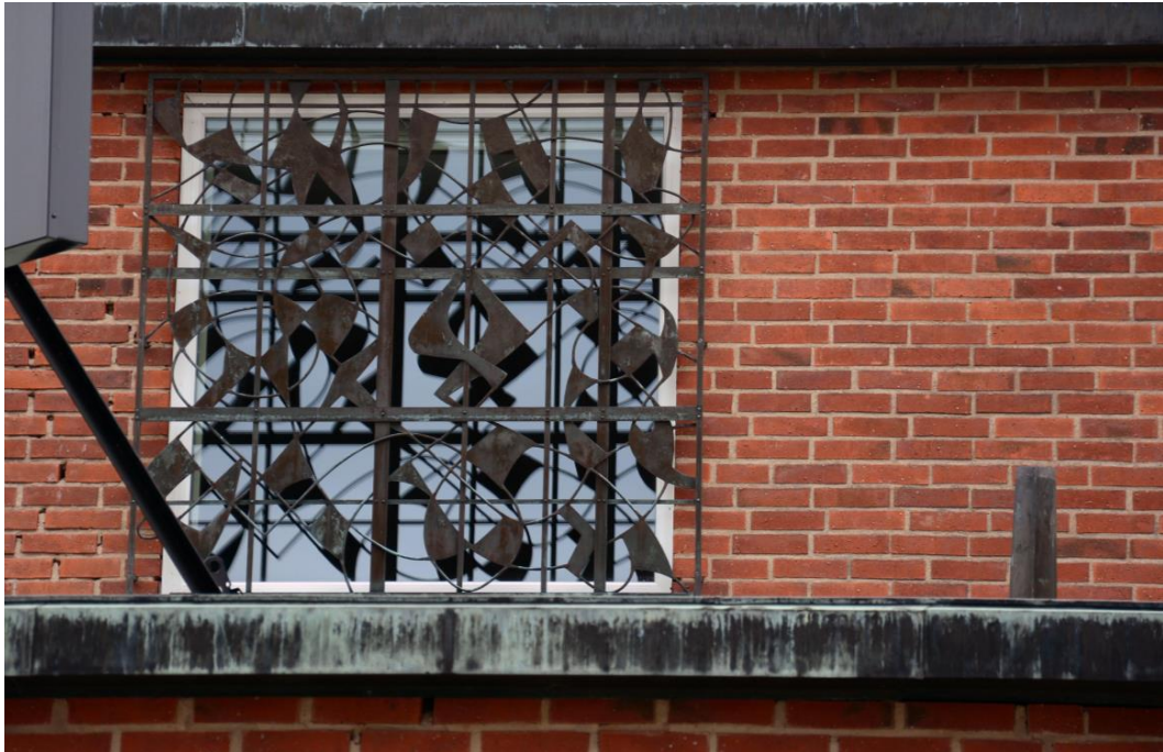
Mönster i kopparplåt framför fönster på församlingsflygelns östra fasad.
