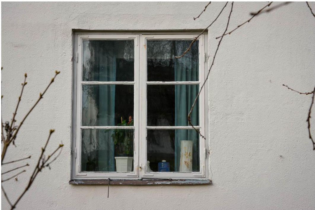
Närbild fönster, fasad mot söder.
